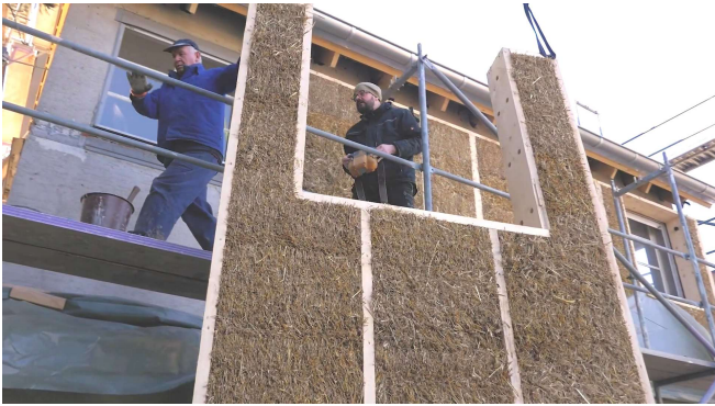
Lorenzin elementin nosto rakennuksen lisäeristeeksi [5]
