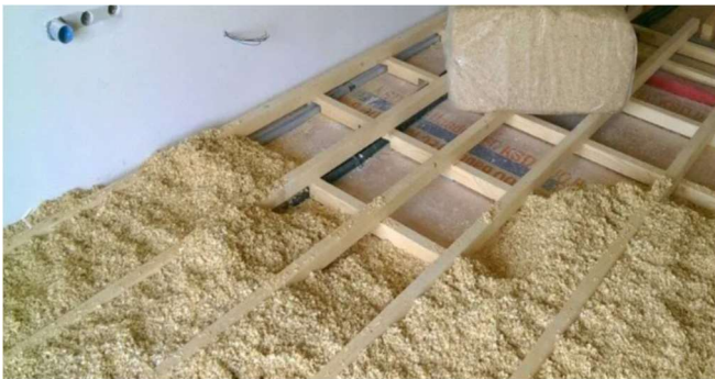
Holz Lehmhausin savetettua höylälastua lattiaeristeenä [9]
