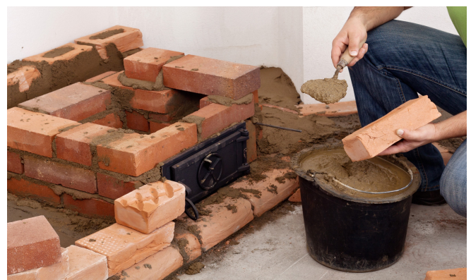
Tulisijan rungon muuraus Fesconin uunilaastilla [6]
