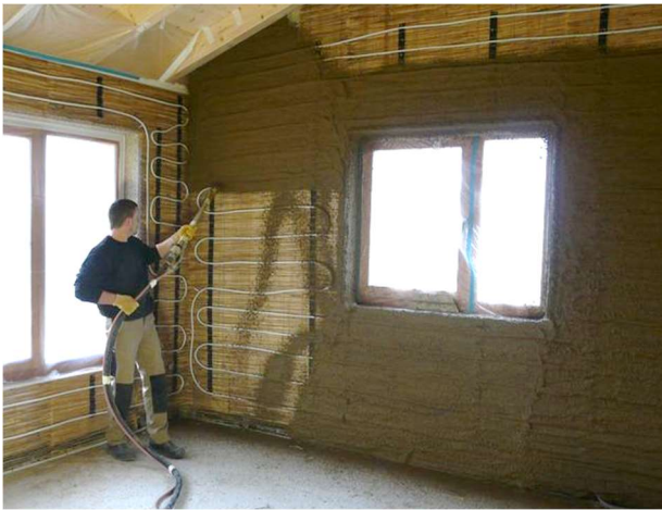
Levita Lehmin savilaastin ruiskurappausta ruokolevylle [3]
