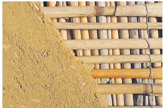
Hiss Reetin rappausmattoja ristiin kiinnitettynä sisätilan paksun savirappauksen vahvistamiseksi [4]
