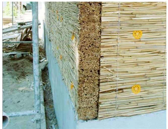
Hiss Reetin ruokolevy kiinnitetty kiviseinän lyöntikiila-ankkureilla lämmöneristeeksi kalkkirappauksen alle [4]
