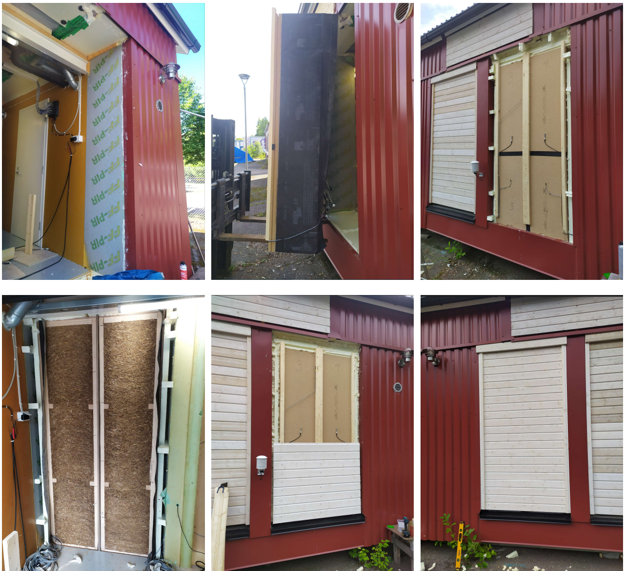
Kuva 4.4 Kuvat rakenteiden asennuksesta
