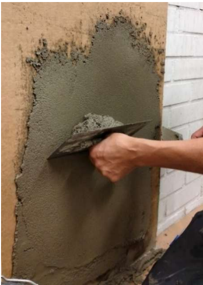
Kuva 2.6 Savilaastin levitys (vasemmalla) ja 3 kerroksinen savirappausjärjestelmä, joka koostuu savi-hiekka-biohiilipohjalaastista (tummanharmaa), savi-hiekka-viimeistelylaastista (vaaleanharmaa) ja savi-tärkkelysmaalista (valkoinen väri) (oikealla).
