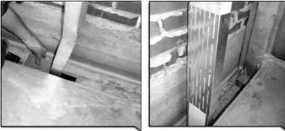
Kuva 4. Termokengän asennus.
