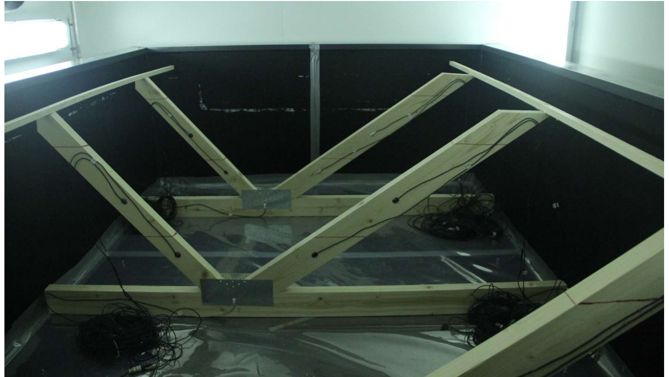
Kattoristikollisen koerakenteen valmistelu ja antureiden asentaminen paikoilleen.
