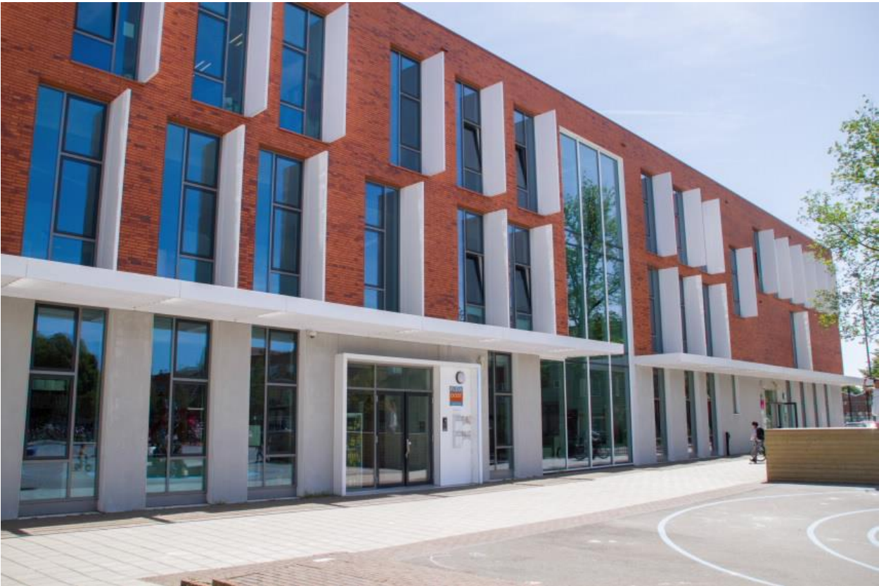
Kuva 4 Energianeutraali Plein Oost -koulu Haarlemissa.
