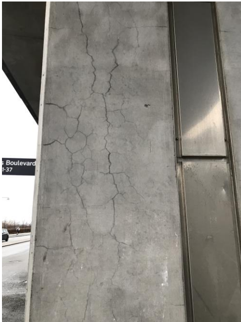
Metrolinjan pilari Örestad, Kööpenhamina
