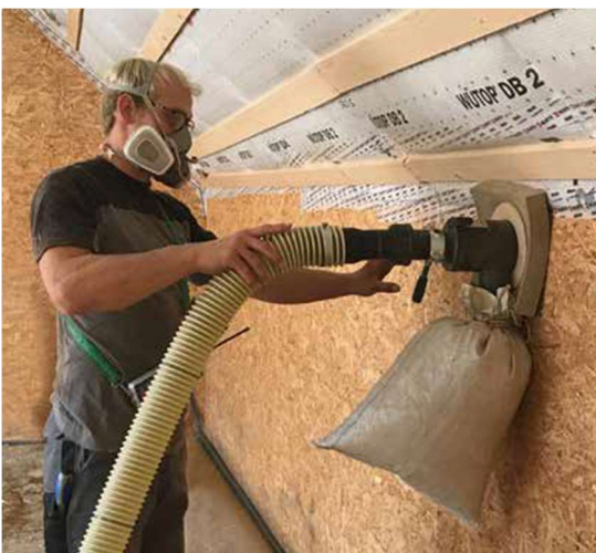
ISO-Strohn eristeen puhallusta seinärakenteeseen [2]
