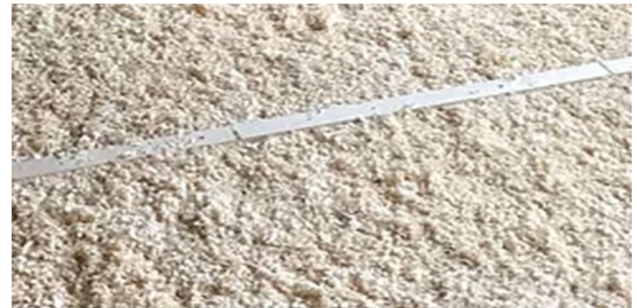
Ehta Talojen höylälástueristettä välipohjassa [1]
