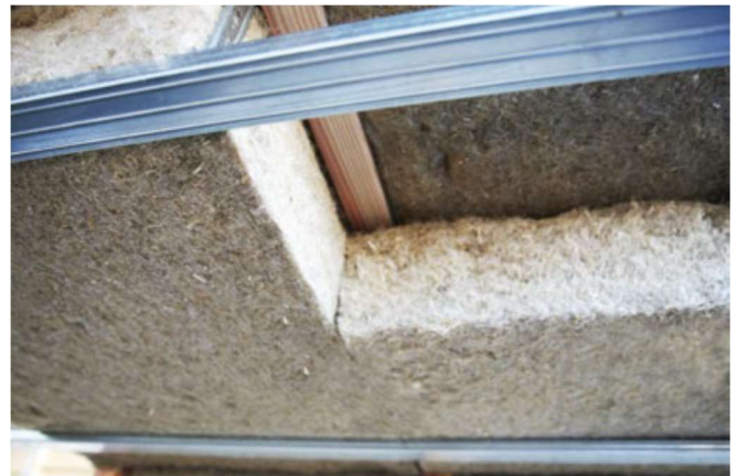
Biofibrin eristevilla välipohjan eristyksessä [2]
