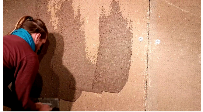
Hanffaserin savilevyt ruuvattu aluslaatan kanssa ennen yllirappausta [7]
