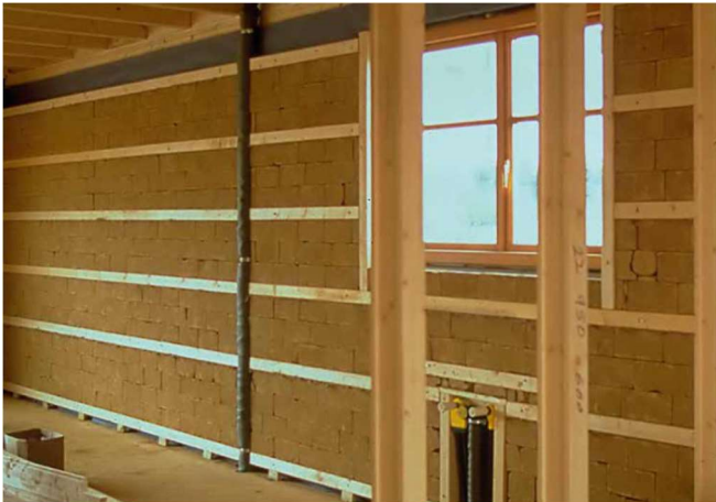
Saksalainen savialan kattojärjestö Dachverband Lehm opastaa mm. Ristikkotalon seinän korjaustyössä (yläkuva) ja III luokan tiiliseinän rakentamisessa (alakuva) [2]
