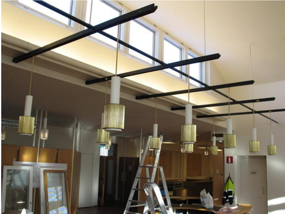
Kaikki alkuperäiset valaisimet kunnostettiin ja niiden tekniikkaa uusittiin.
