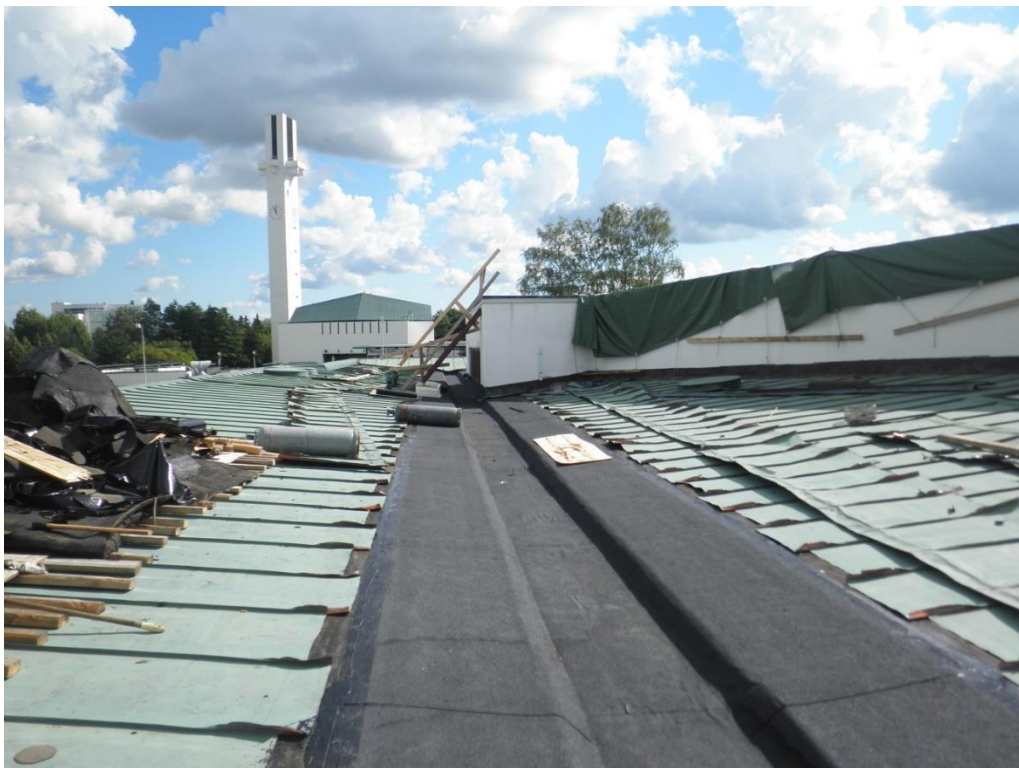
Kuvassa uusi aluskermi jonka päällä uusi kumibitumihuopa sekä paikalleen jäävä alkuperäinen kermi.
