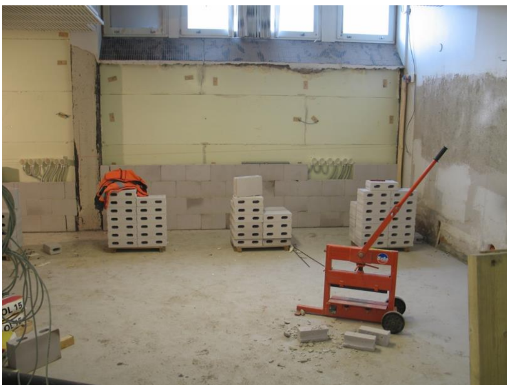
Kalkkihiekkakivien muuraus käynnissä.
