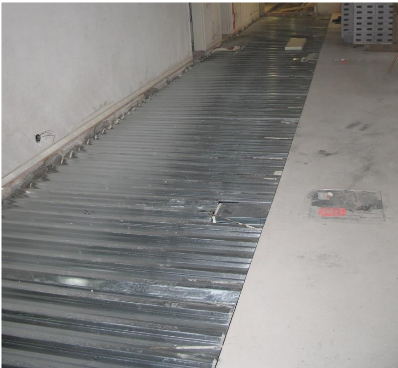
Kanaalin päälle tulevan kannen valu suoritettiin käyttämällä poimulevyä muottina.
