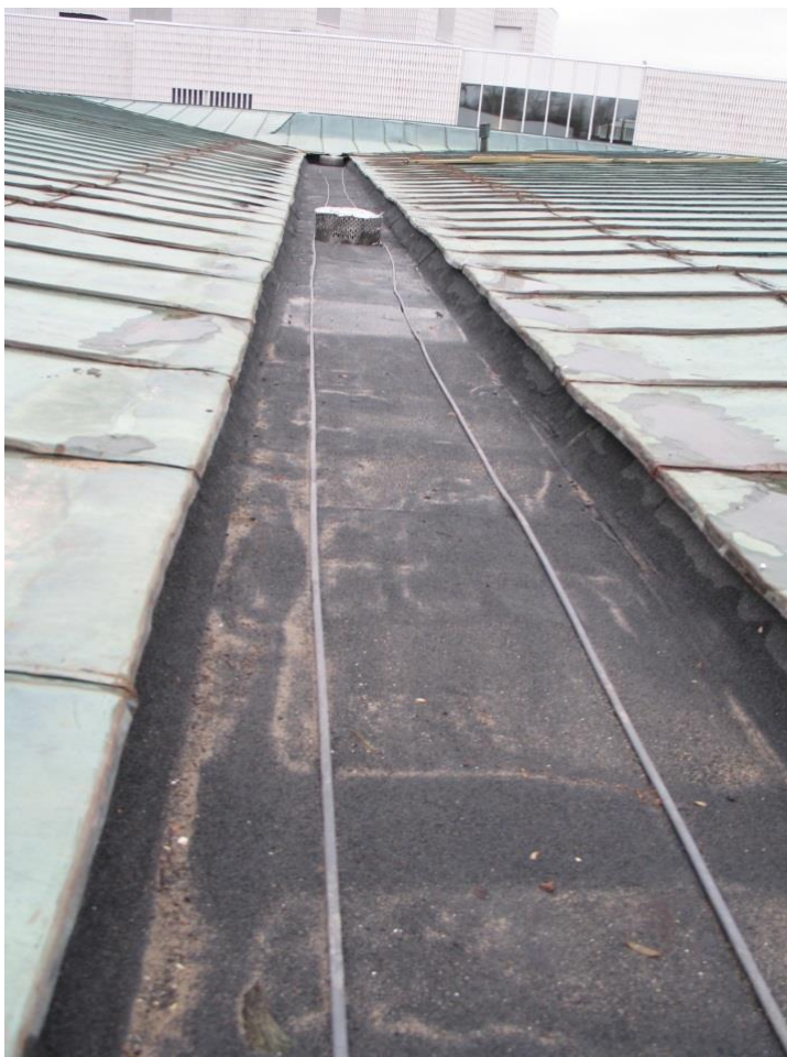
Valmis kattokouru lämmityskaapeleineen ja kattokaivoineen.
