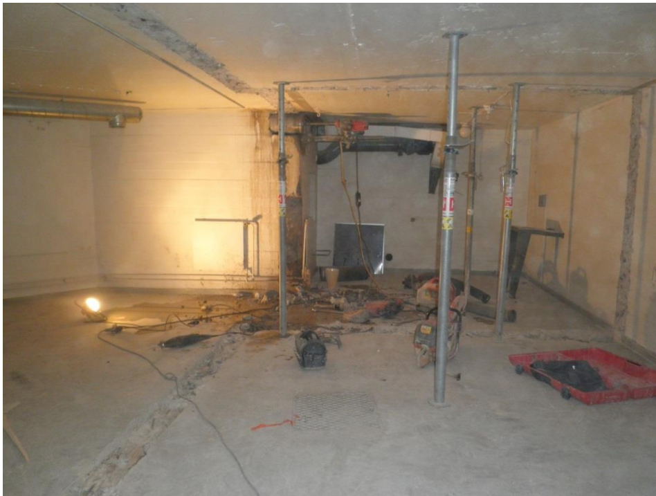
Kantavat väliseinät purettuna ja väliaikaiset tuet paikoillaan.
