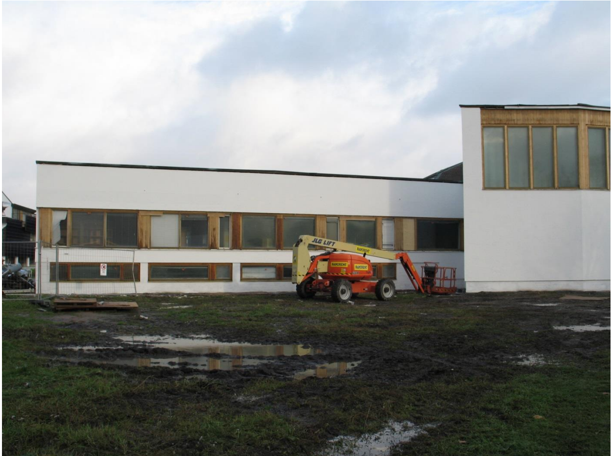
Etelän puoleinen seinä maalattuna.
