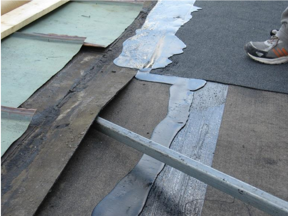
Kuvassa uusi aluskermi jonka päällä uusi kumibitumihuopa sekä paikalleen jäävä alkuperäinen kermi.
