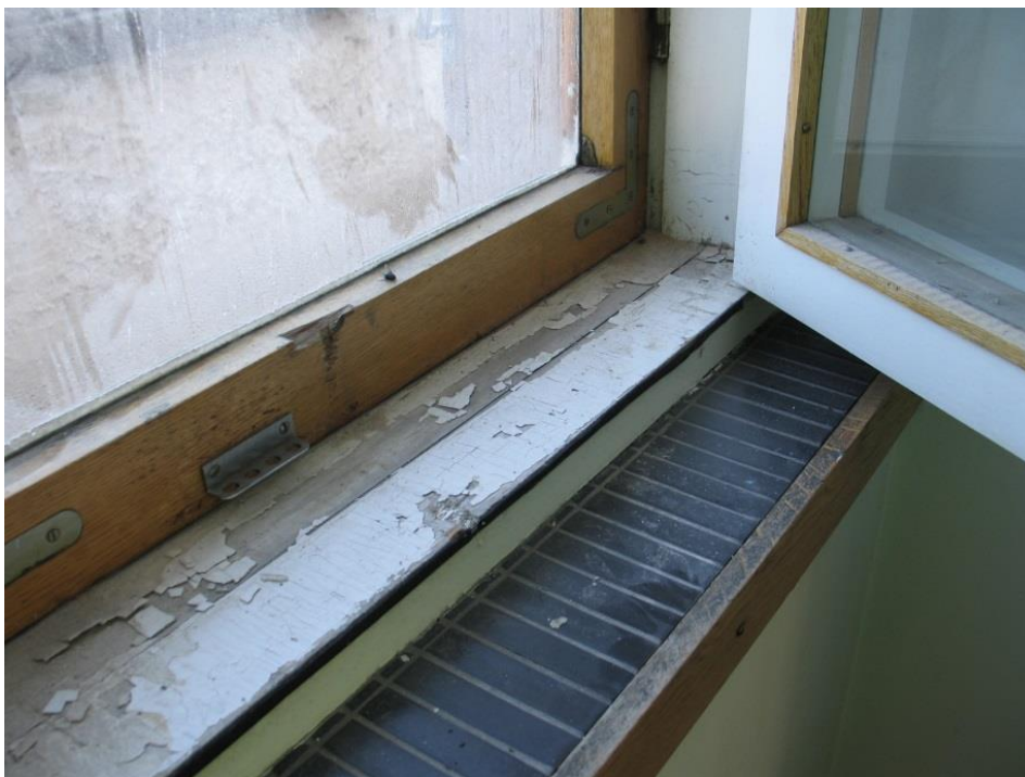
Pohjoispuolen ikkuna ennen kunnostusta.
