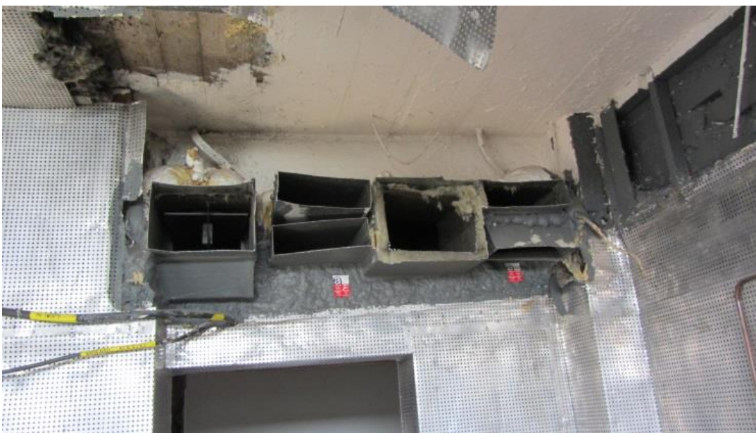
Vanhat ilmanvaihtokanavat olivat pääsääntöisesti ns. kanttikanavaa.
