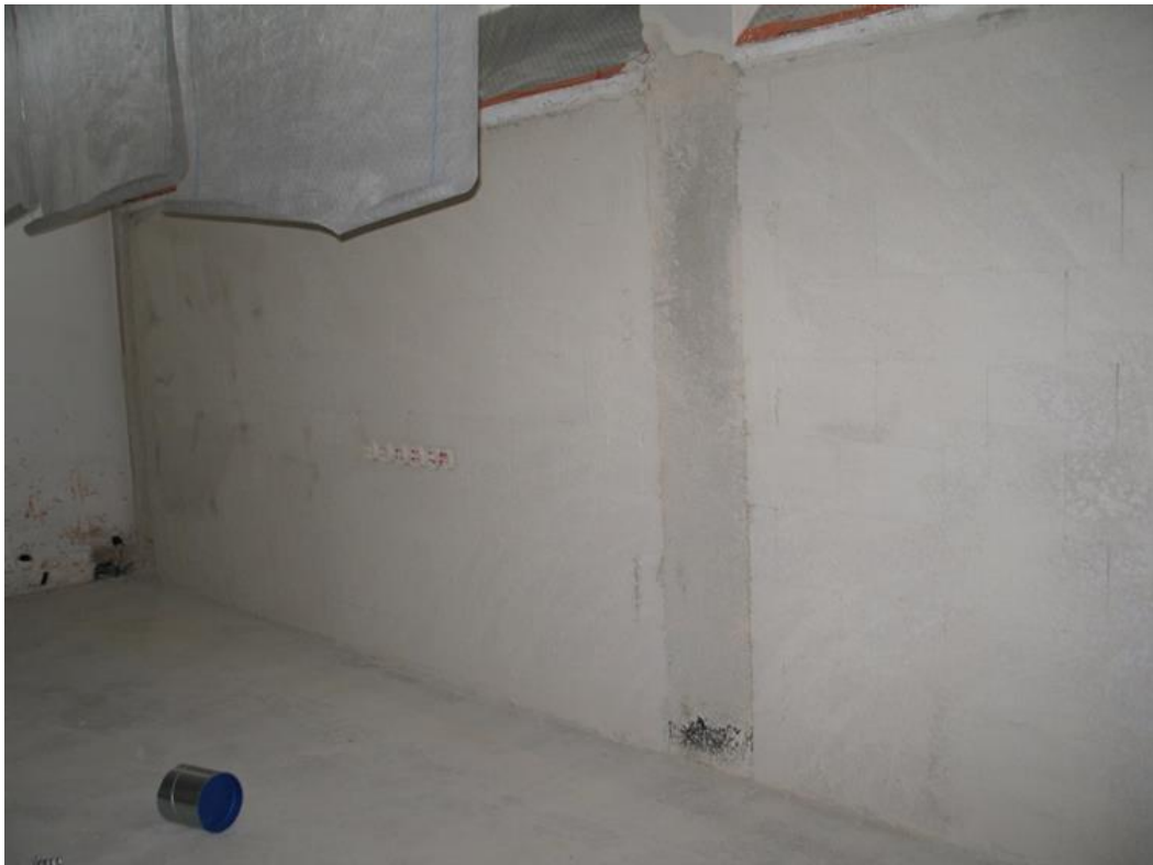
Uudistettu seinä pohjarapattuna.
