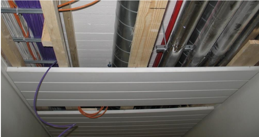
Metallipaneelien asennus käynnissä.
