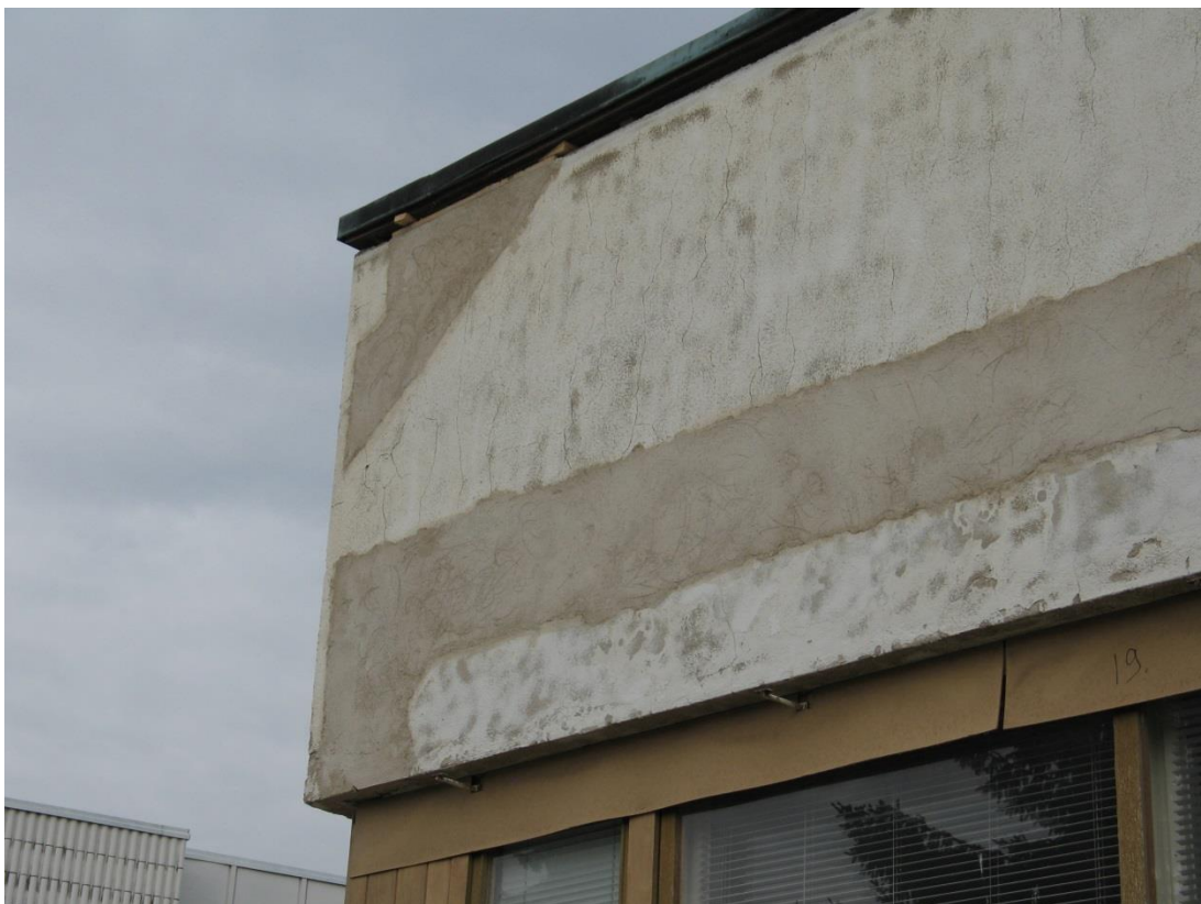
Etelän puolen julkisivun paikkausjäljen jälkeä.
