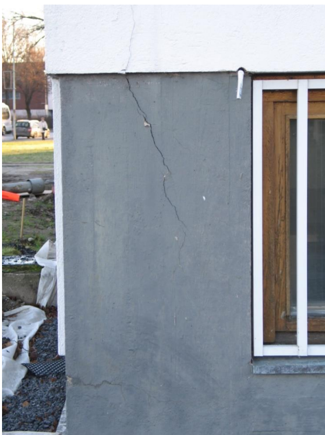
Sokkeli ennen korjauksia.
