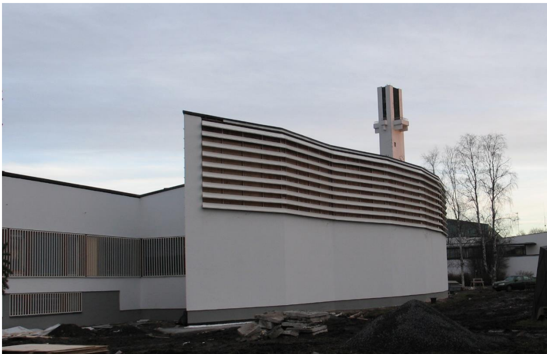
Alumiinisäleiköt paikoilleen asennettuna kunnostuksen jälkeen.
