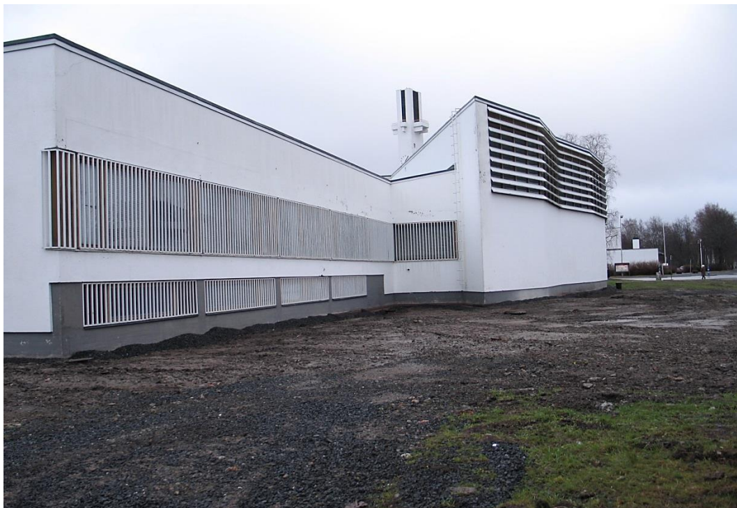
Etelän puoleinen julkisivu ennen korjausta.
