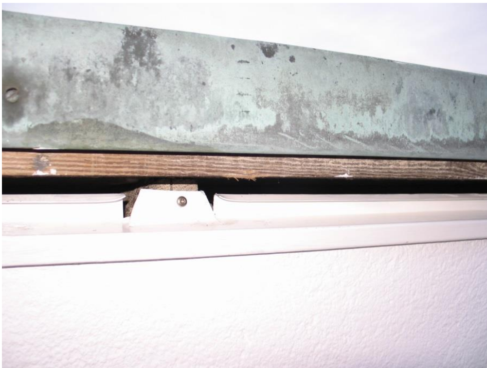
Uusi alempi alumiinilista asennettuna. Tuuletusrako selvästi auki.
