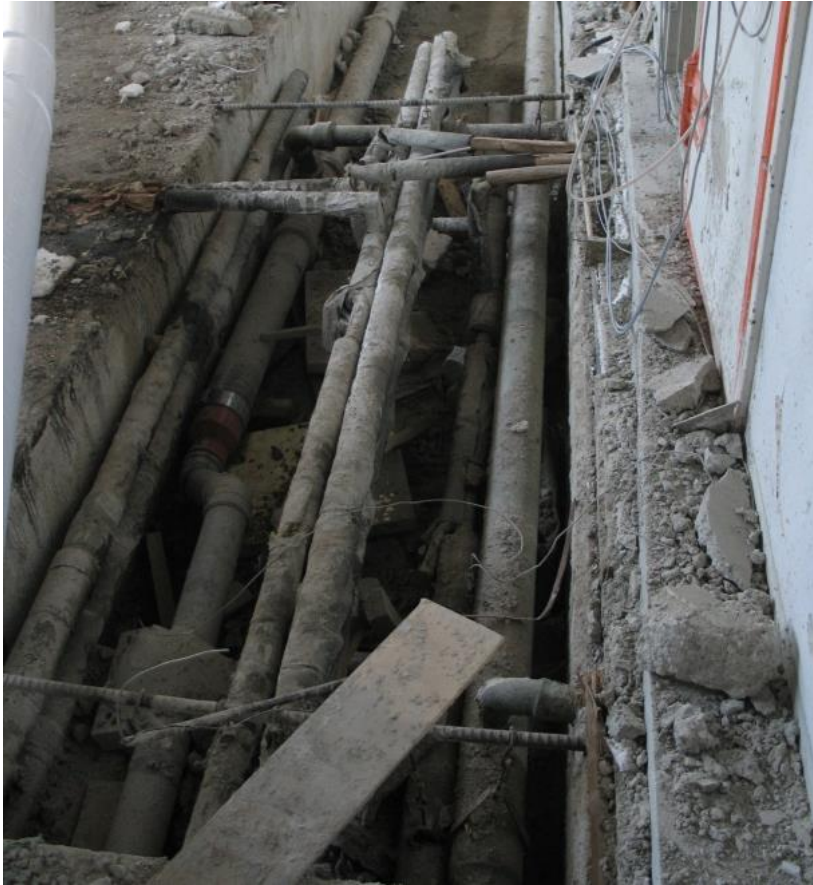
Alkuperäiset putkiasennukset kanaalissa.
