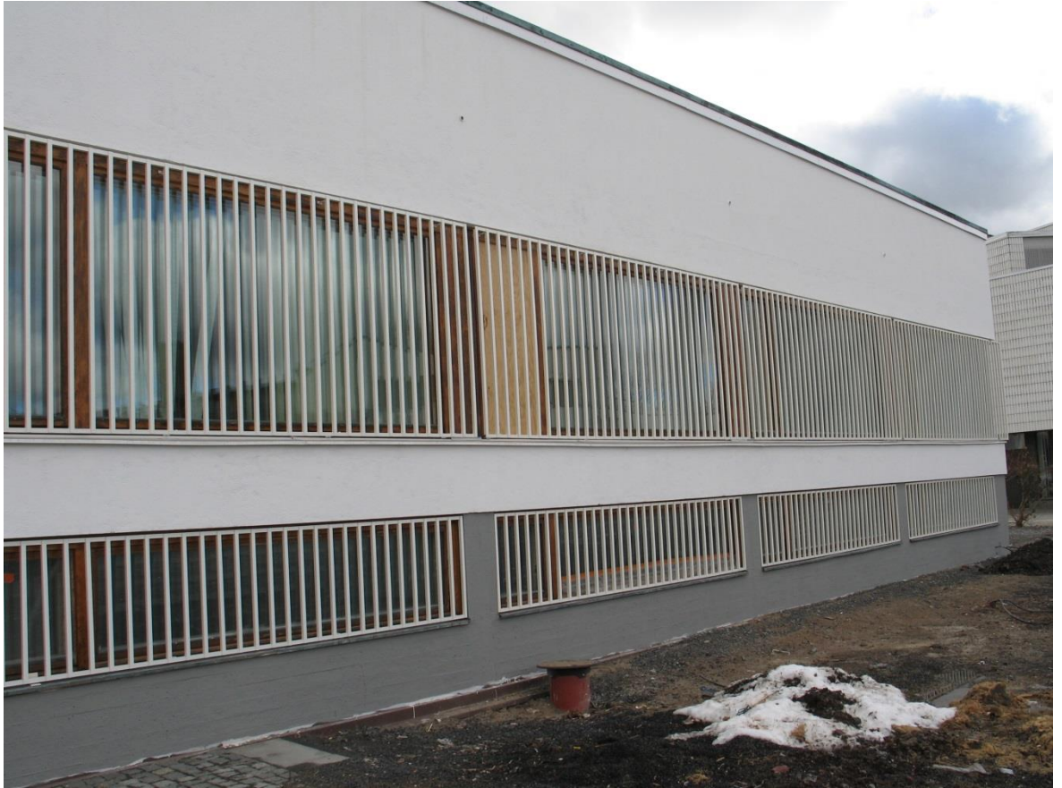
Pääsisäänkäynnin viereistä alumiinisäleikkökenttää.
