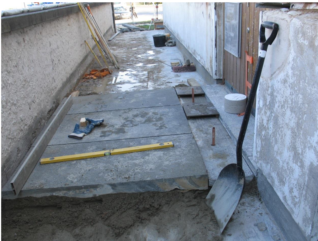
Graniittilaattojen asennus käynnissä.
