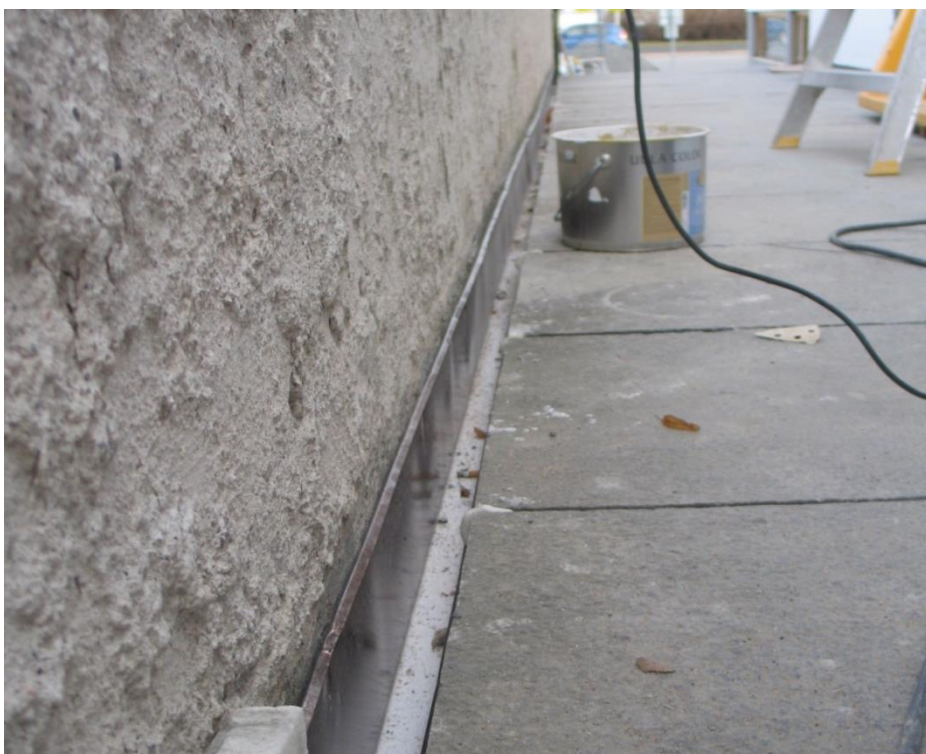
Kuparinen poistokouru paikoillaan.
