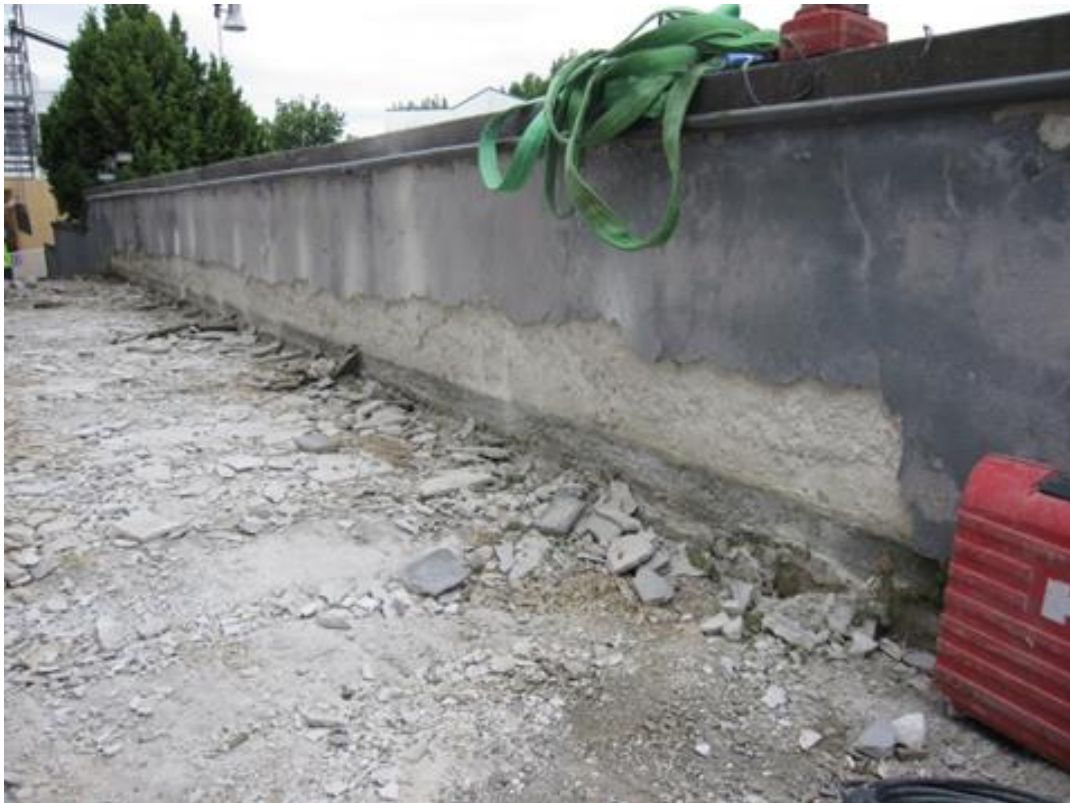
Betonikaiteen rappaus poistettiin kokonaisuudessaan.
