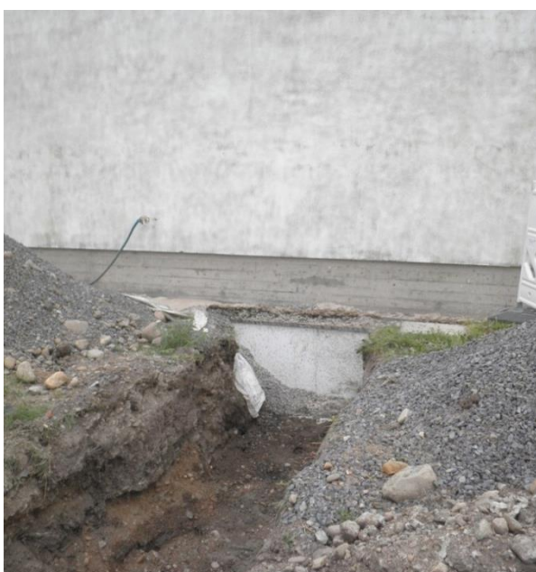
Vasemmalla kaukolämmön kanaalin liittymäkohta. Oikealla kaukolämpökanavan veto läpiviennistä alapohjakanaaliin.
