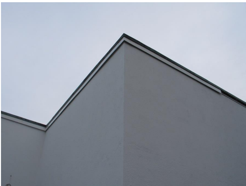
Päällimmäinen alumiinilista asennettuna.
