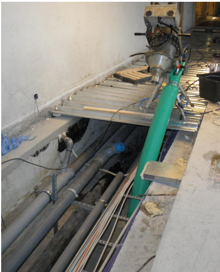
Runkoviemärin sukitus käynnissä
