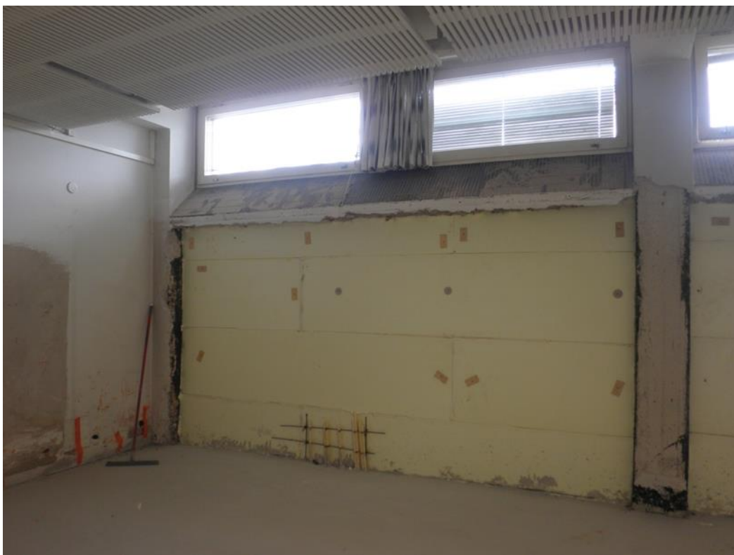
Lämmöneriste asennettuna.
