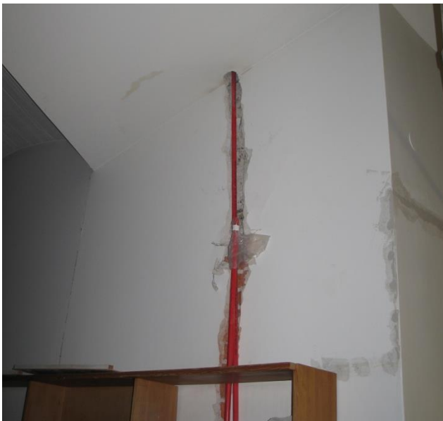
Korjaustyöt onnistuttiin tekemään vähillä roilotuksilla.
