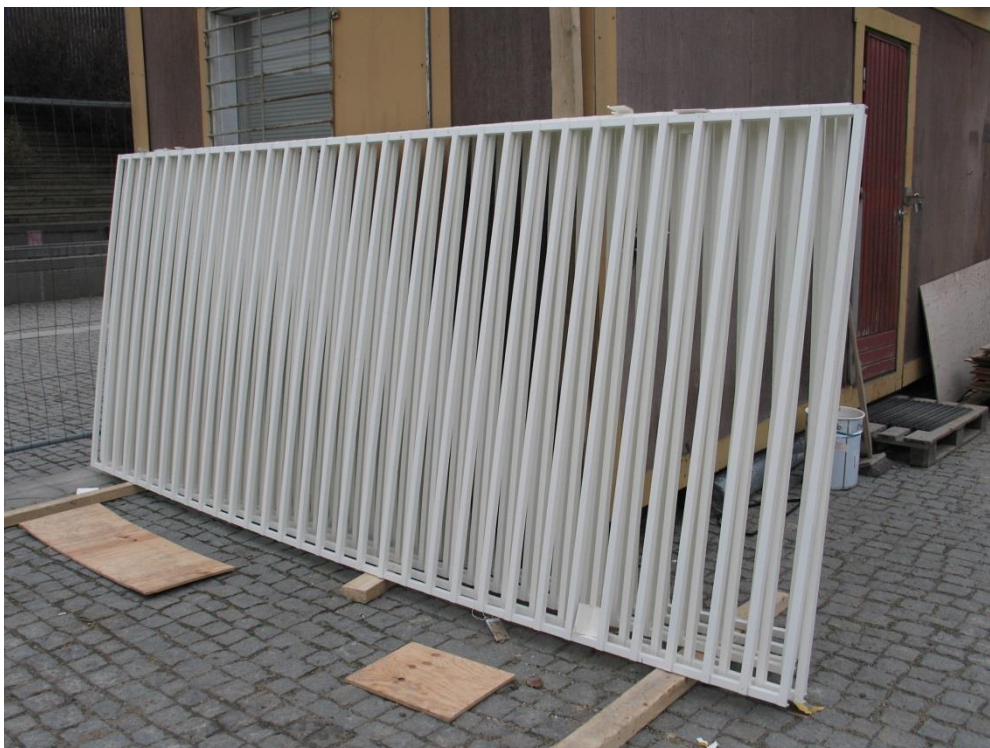
Kunnostetut alumiinisäleet odottamassa asennusta.
