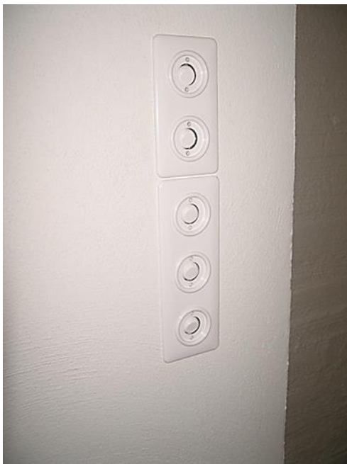
Kytkin ja pistorasiakalusteet uusittiin 60-luvun mukaisilla osilla.
