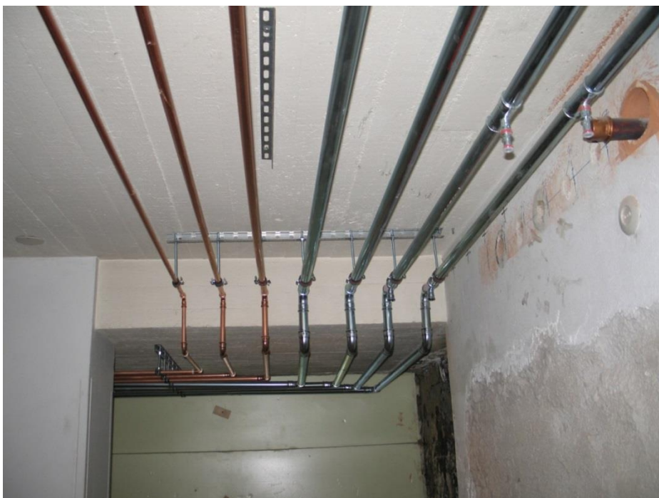
Uudet käyttövesi- ja lämmitysverkoston putket.
