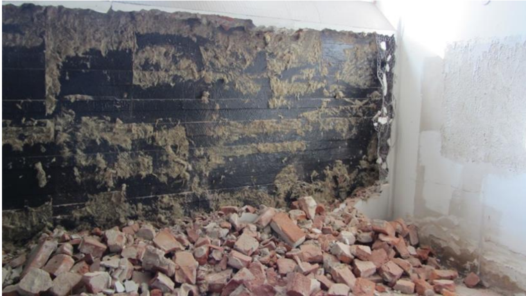
Osasta maanvastaisia ulkoseiniä purettiin sisäkuoren tiilimuuraus ja lämmöneriste.
