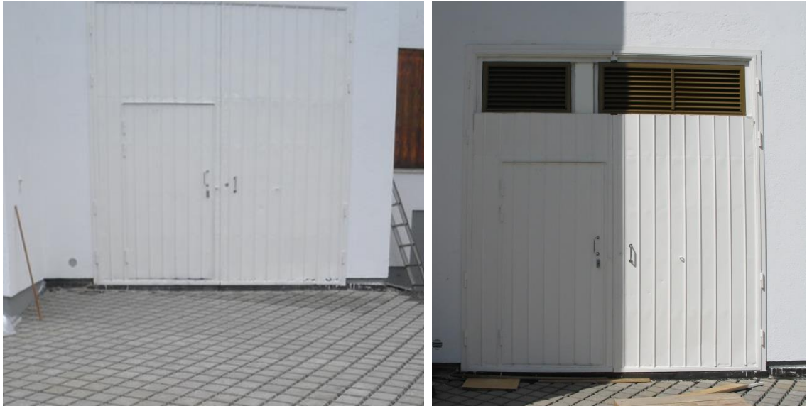
Autotallin ovi ennen ja jälkeen korjauksen.
