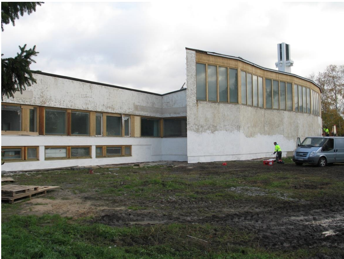
Etelän puoleinen seinä työn alla.
