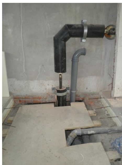
Vasemmalla kaukolämmön kanaalin liittymäkohta. Oikealla kaukolämpökanavan veto läpiviennistä alapohjakanaaliin.
