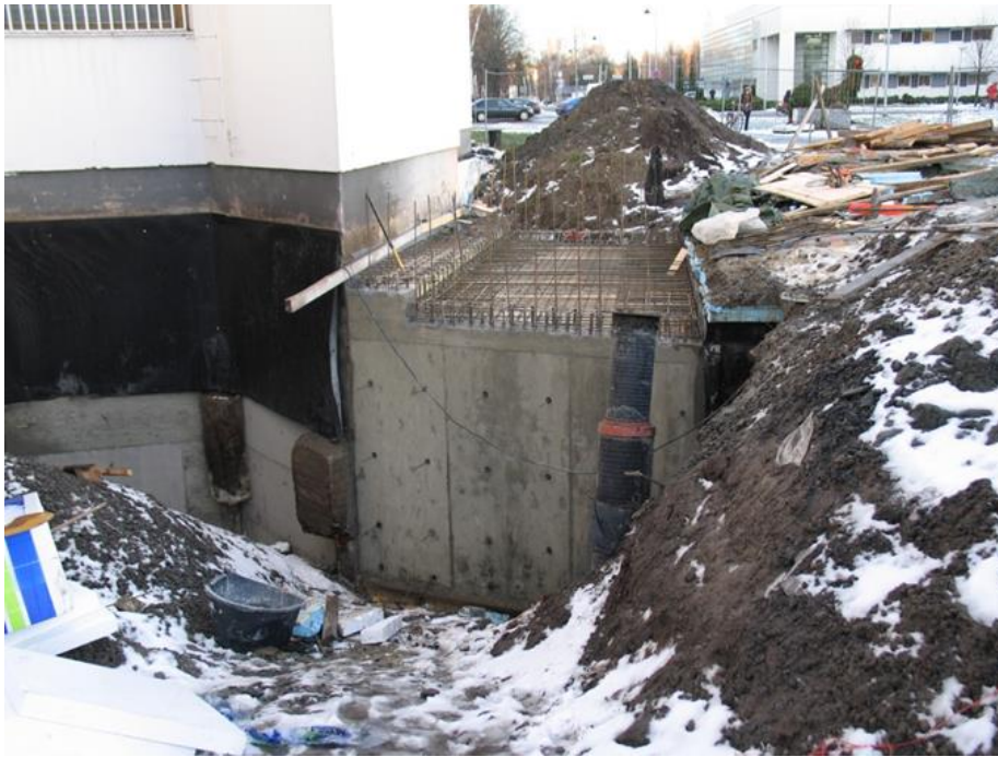
Yhdyskäytävän katon raudoitus.
