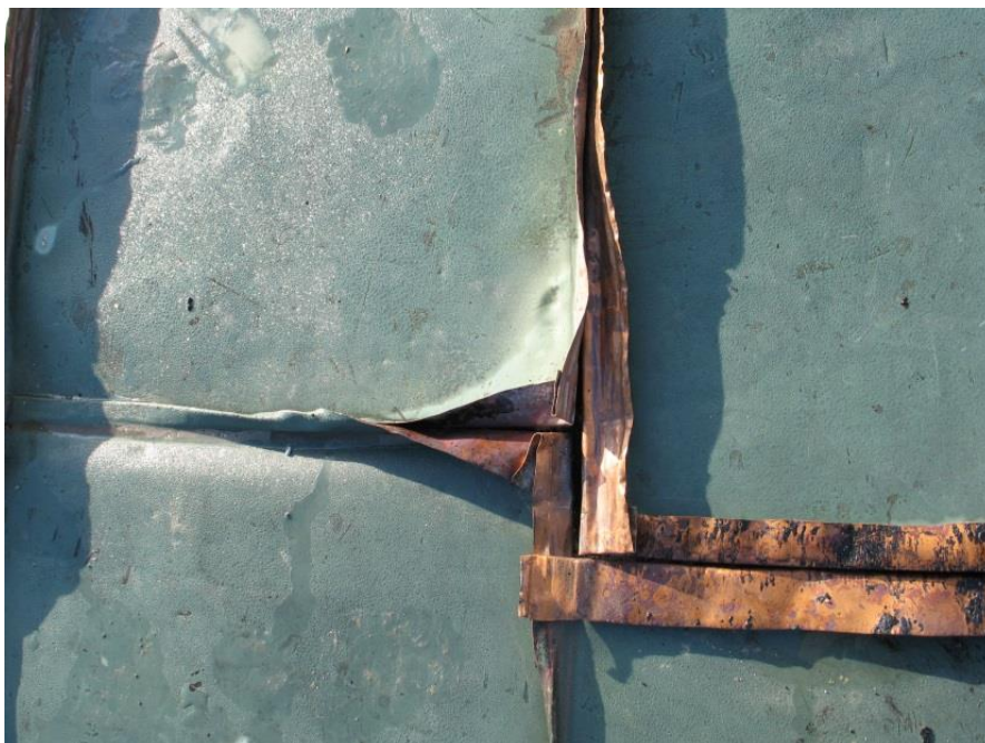
Kuvassa haastava neljän kuparipellin liittymäkohta.
