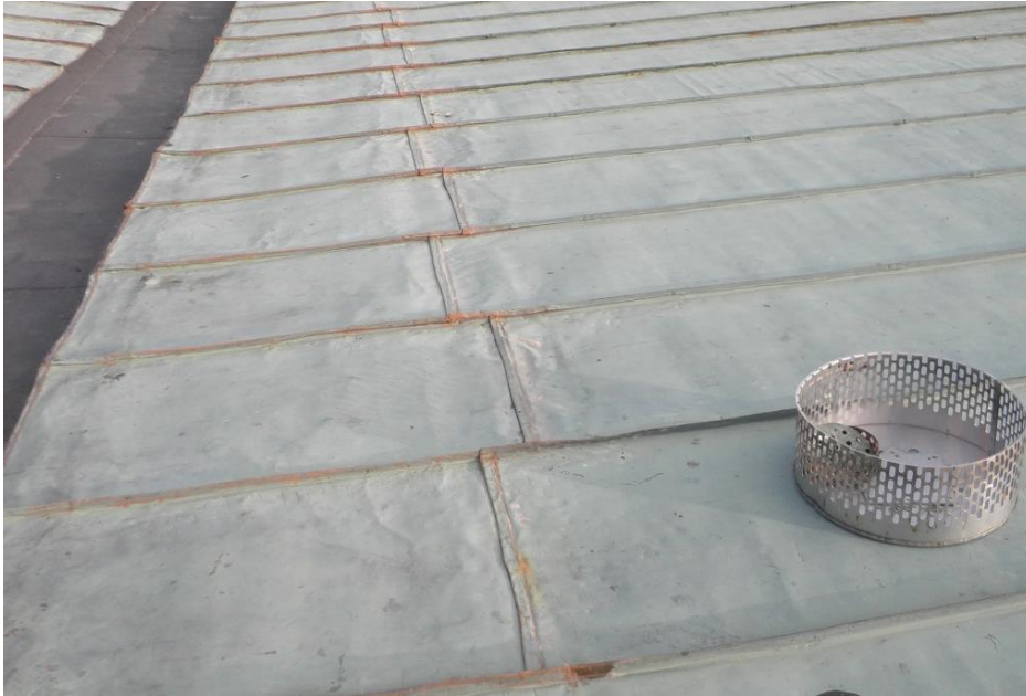
Kuvassa valmiit saumat ja kattokaivon rst-kansi.
