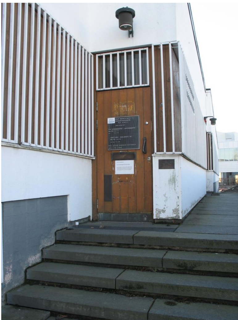
Sivuovi ennen korjausta.
