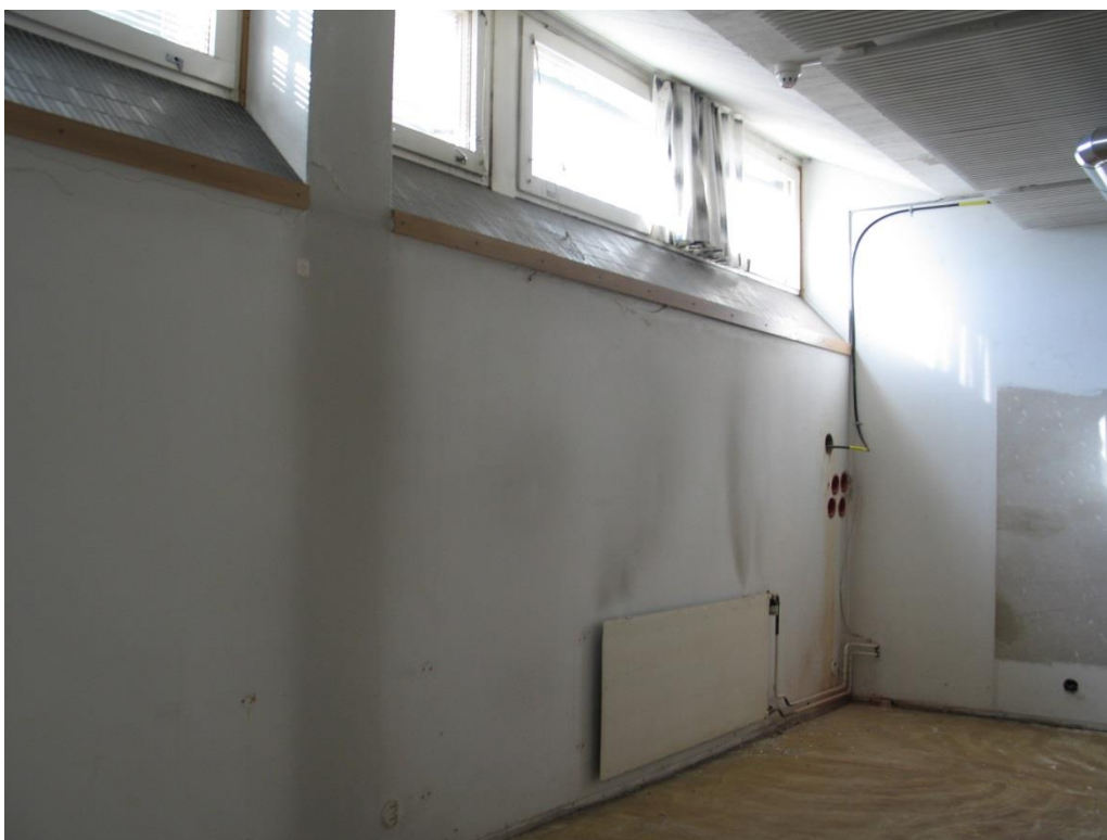
Kuvassa vino ikkunapenkki ja lämmityspatteri ennen purkutöitä.
