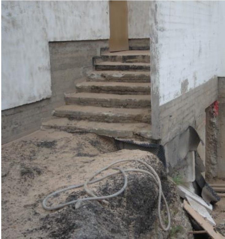
Länsipäädyn graniittiporras korjattiin samoilla periaatteilla kuin pääsisäänkäynnin graniittiporras.
