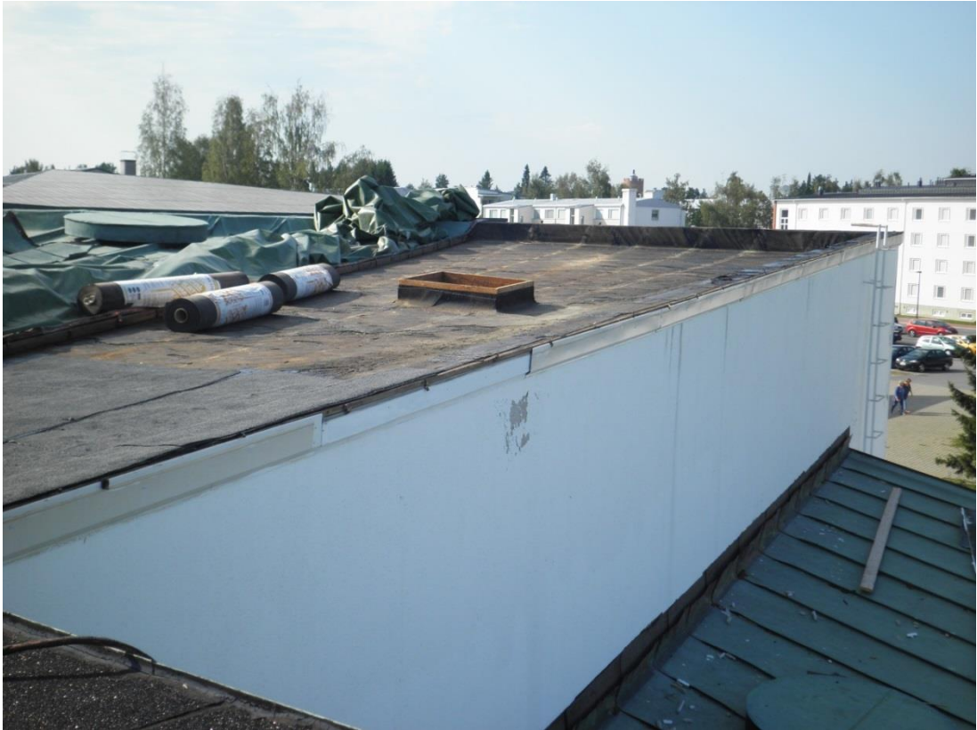
Purkutyöt tehtynä ja vesieristeiden asennus alkamassa.
