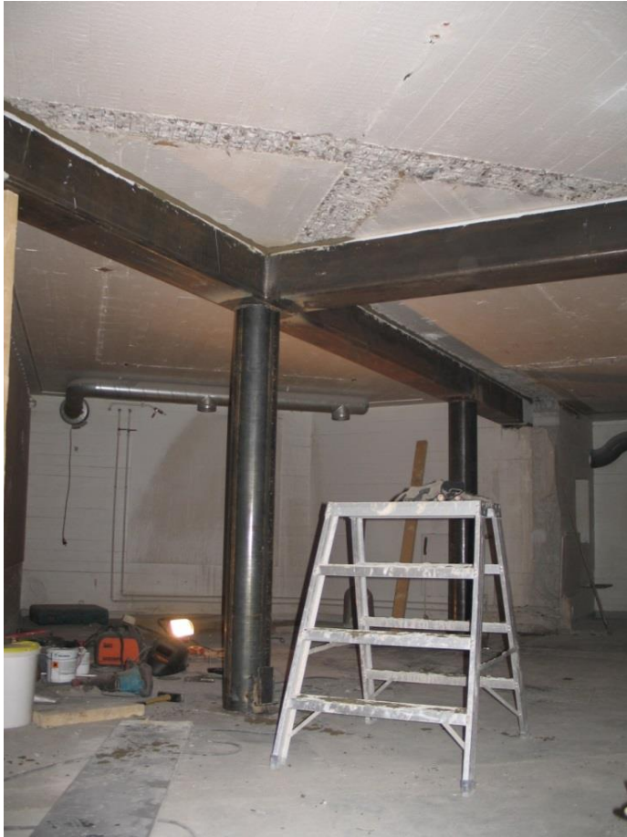
Uudet teräksiset pilarit ja palkit asennettuna.
