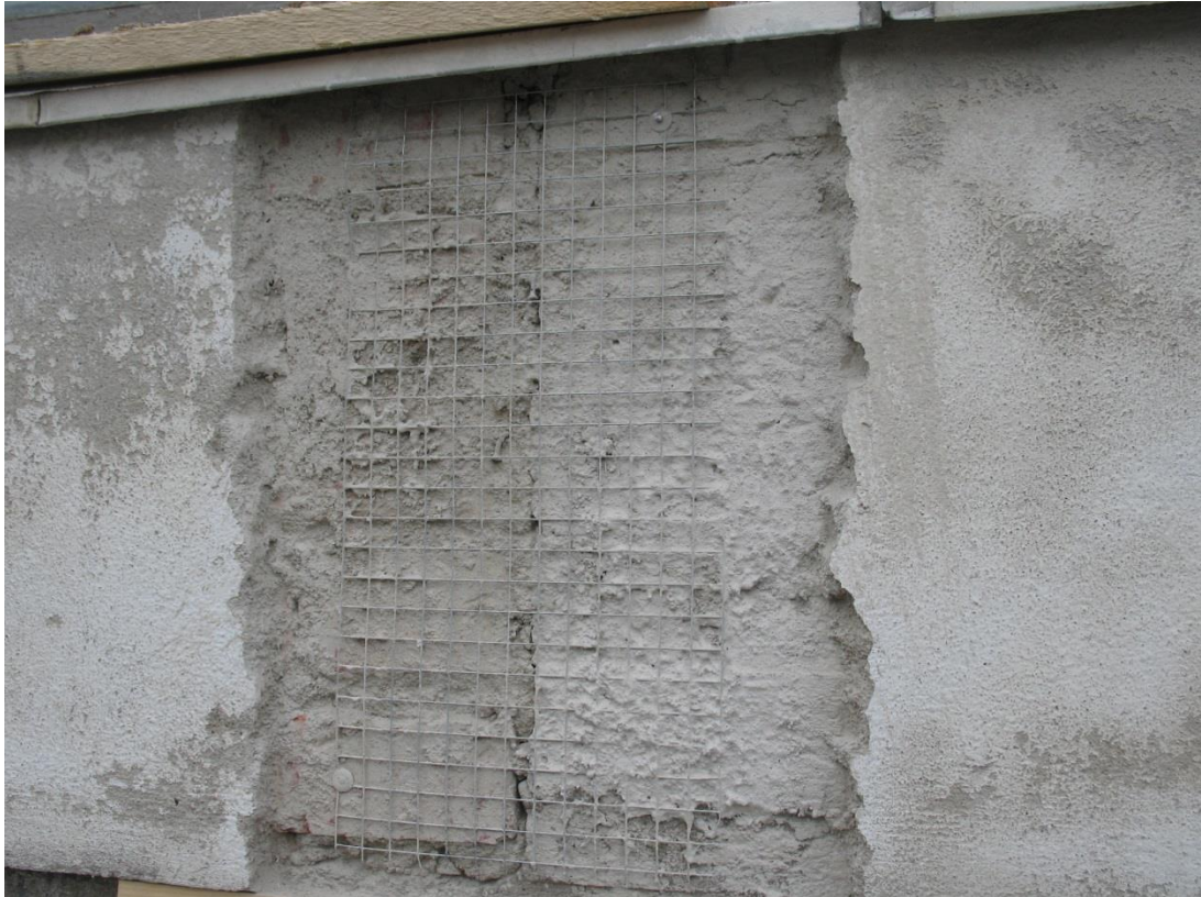
Kuumasinkitty rappausverkko ja tartuntarappaus.
