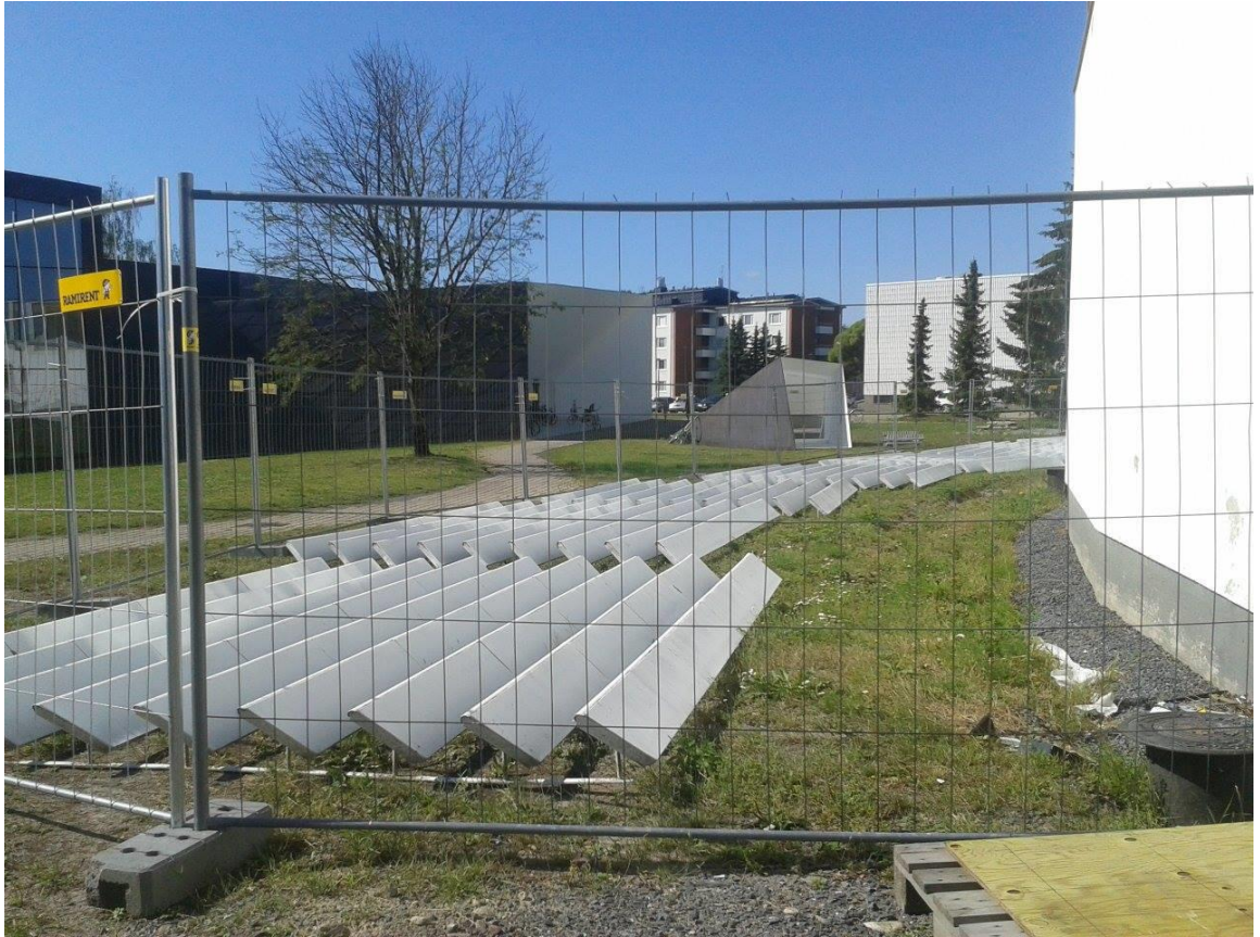
Alumiiniset vaakasäleiköt irrotettuna odottamassa kuljetusta kunnostukseen.
