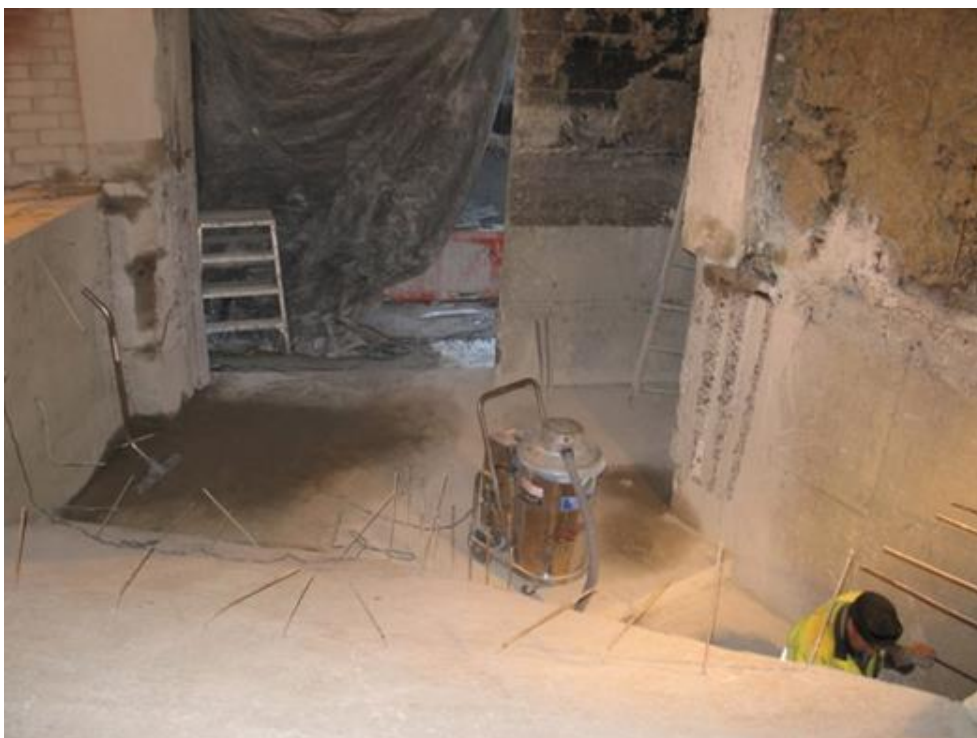
Yhdyskäytävän liittymän pohjavalut suoritettuna
