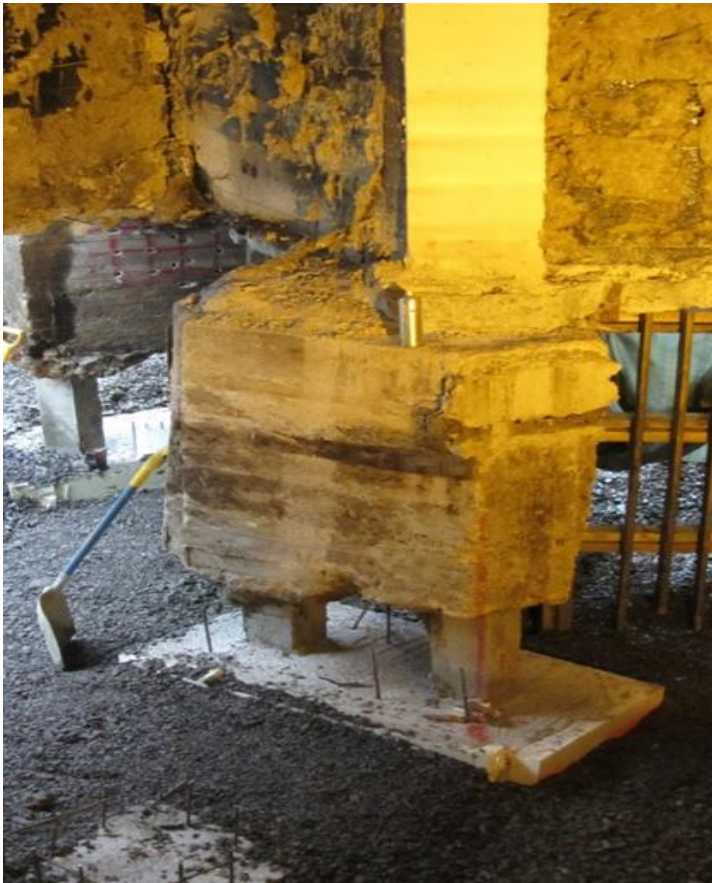
Perustusten vahvistustyöt tehtynä.
