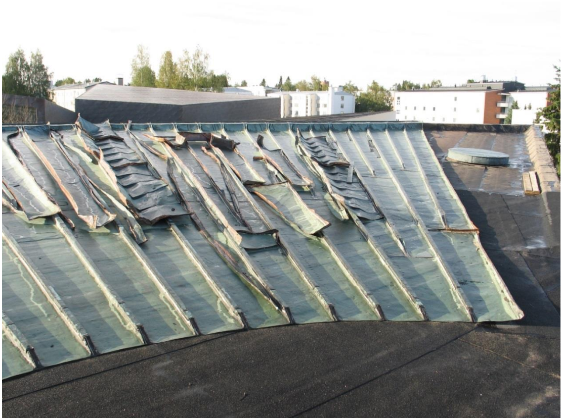
Purkutyöt tehtynä ja vesieristeiden asennus alkamassa.
