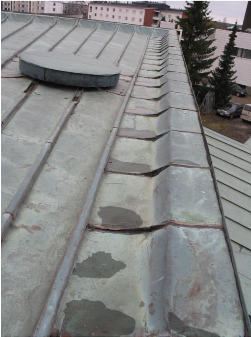
Kunnostustyöt valmiina ylemmällä katolla.
