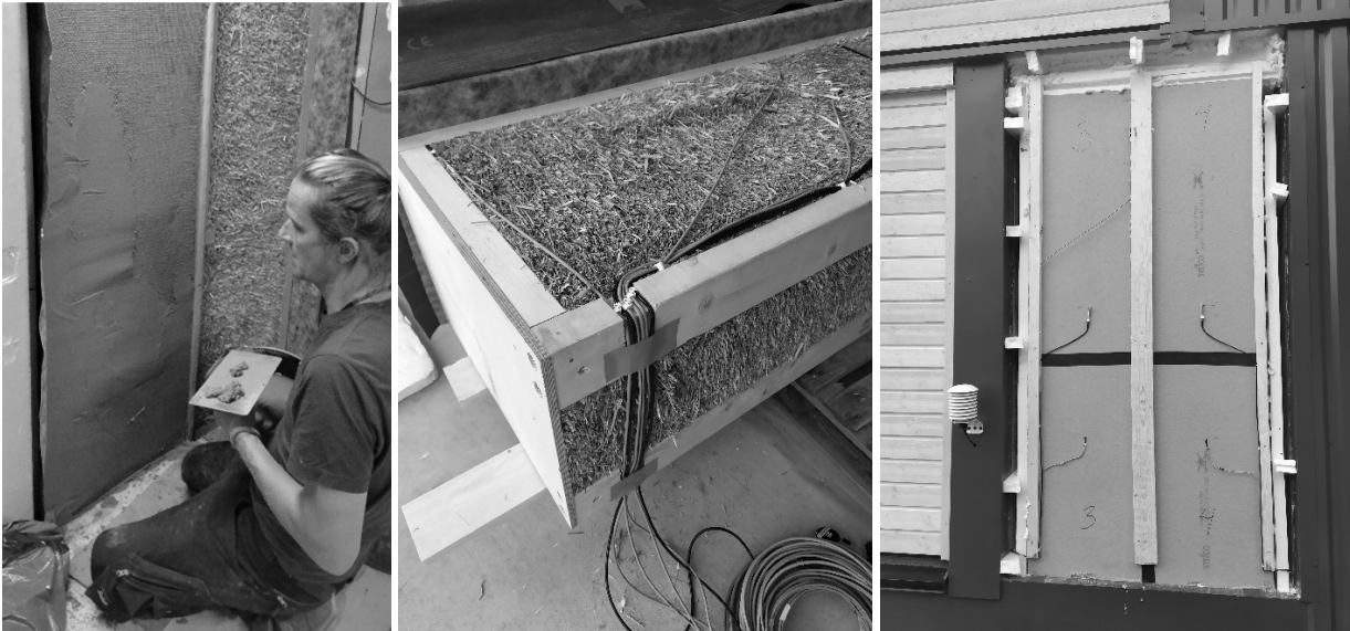
Kuva 1. Olkielementin sisäpinnan savirappausta ja ulkopinnan anturointia.
