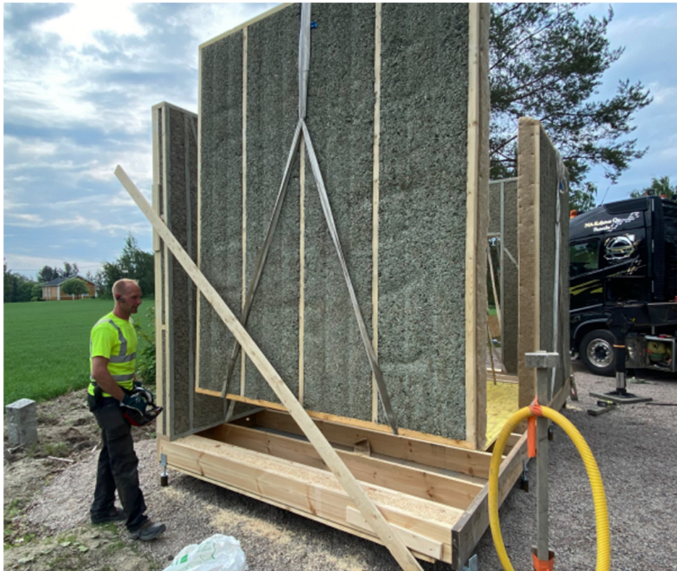
Kuva 14 Kevytsavielementin asennusta nosturilla. [43]
